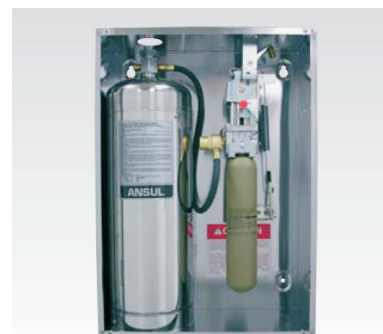
Središnja jedinica sustava ugrađena je u ormarić izrađen od nehrđajućeg čelika.
